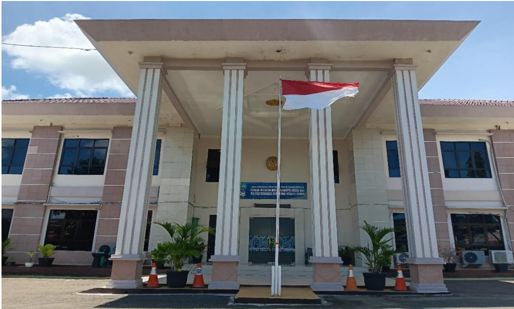
Gambar 3 Gedung Pengadilan Negeri Rangkasbitung
